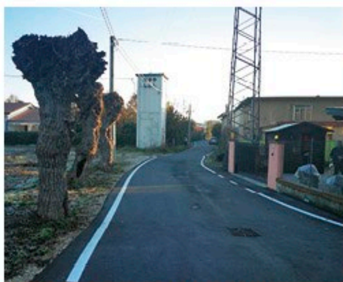
Lavori di asfaltatura Via Tombolata
