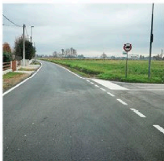
Lavori di asfaltatura Via Traversagni
