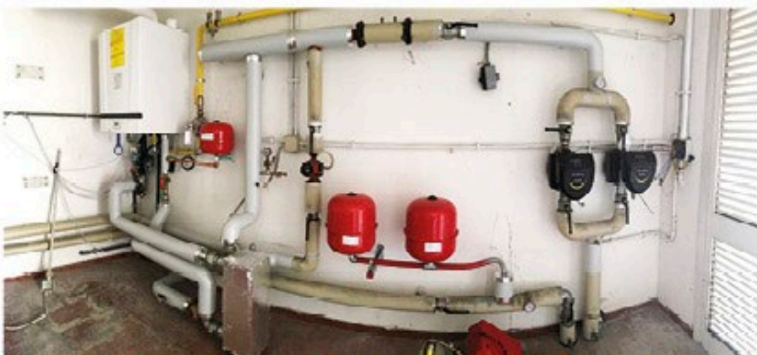
Sostituzione e riqualificazione della centrale termica del Centro Polivalente
