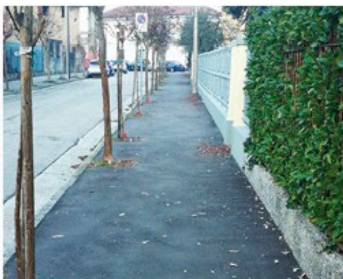
Manutenzione marciapiedi Via Stazione
